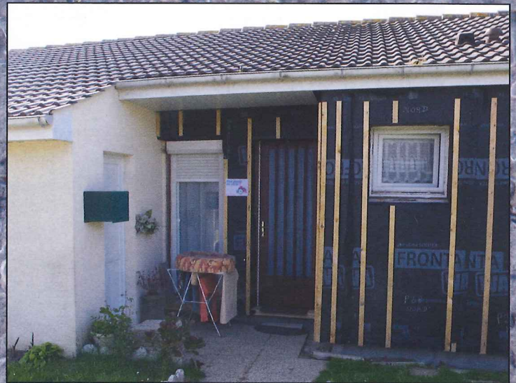
Un bardage sera ensuite posé sur l'isolation.
