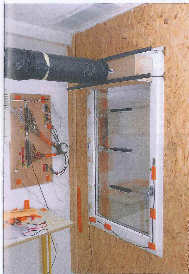
Avant d'être posées, les fenêtres pariéto-dynamiques ont été testées en laboratoire.
