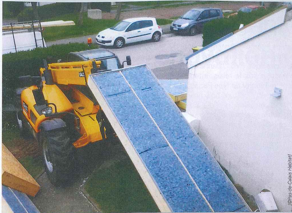
Les caissons d'isolation en bois, emplis de métisse, ont été préfabriqués en usine.
