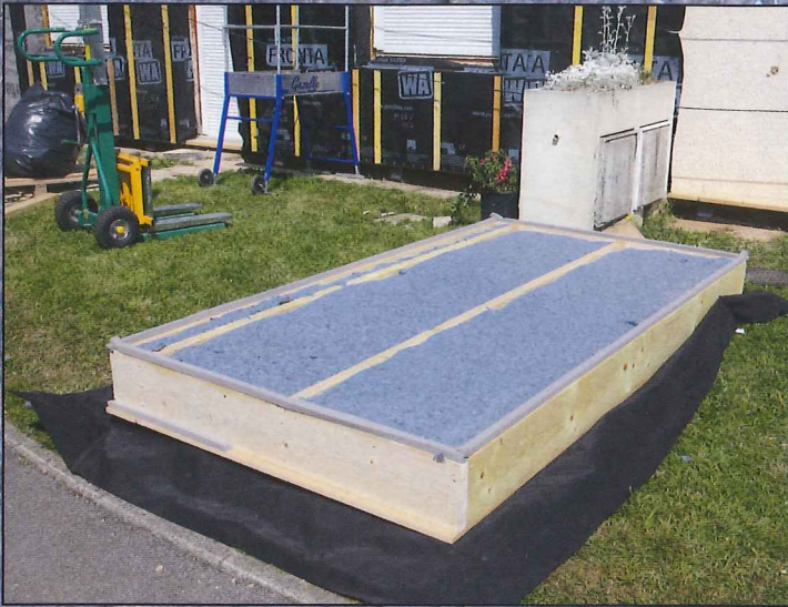
Ce coffrage ci-dessus, est une innovation, que l'on adapte à chaque type de façade.
