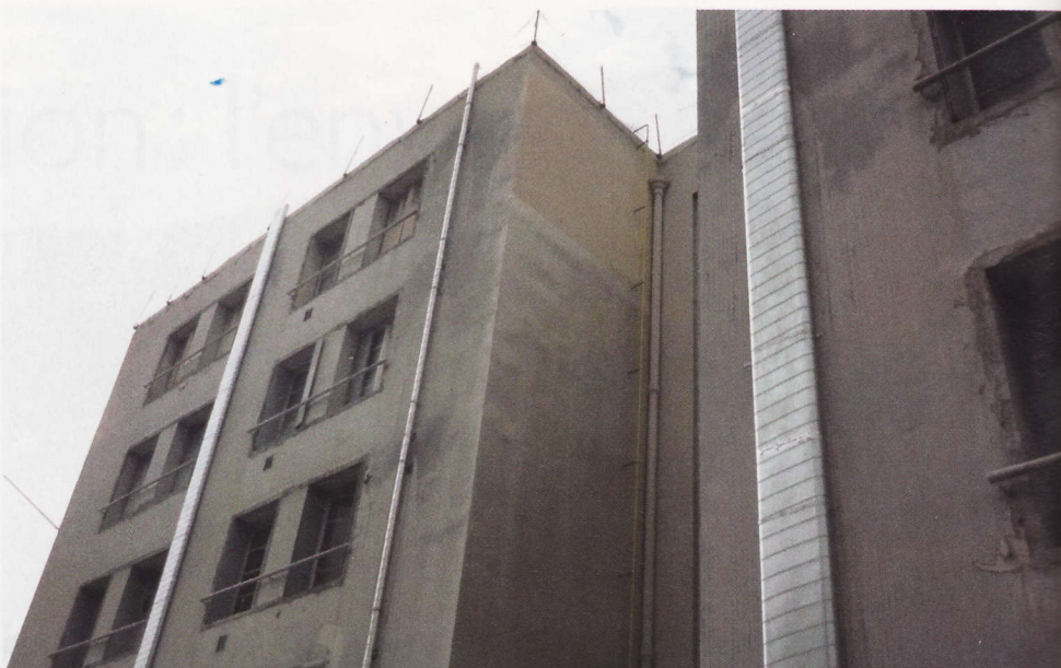
La résidence Maréchal-Leclerc (25 logements), située à Bourgoin-Jallieu (38), a utilisé pour la première fois en France des conduits posés à l'extérieur. Ici, avant la pose de l'isolant, on distingue les conduits parfois ronds, parfois oblongs, ainsi que l'alimentation en gaz pour la chaufferie en toiture (conduit jaune).
