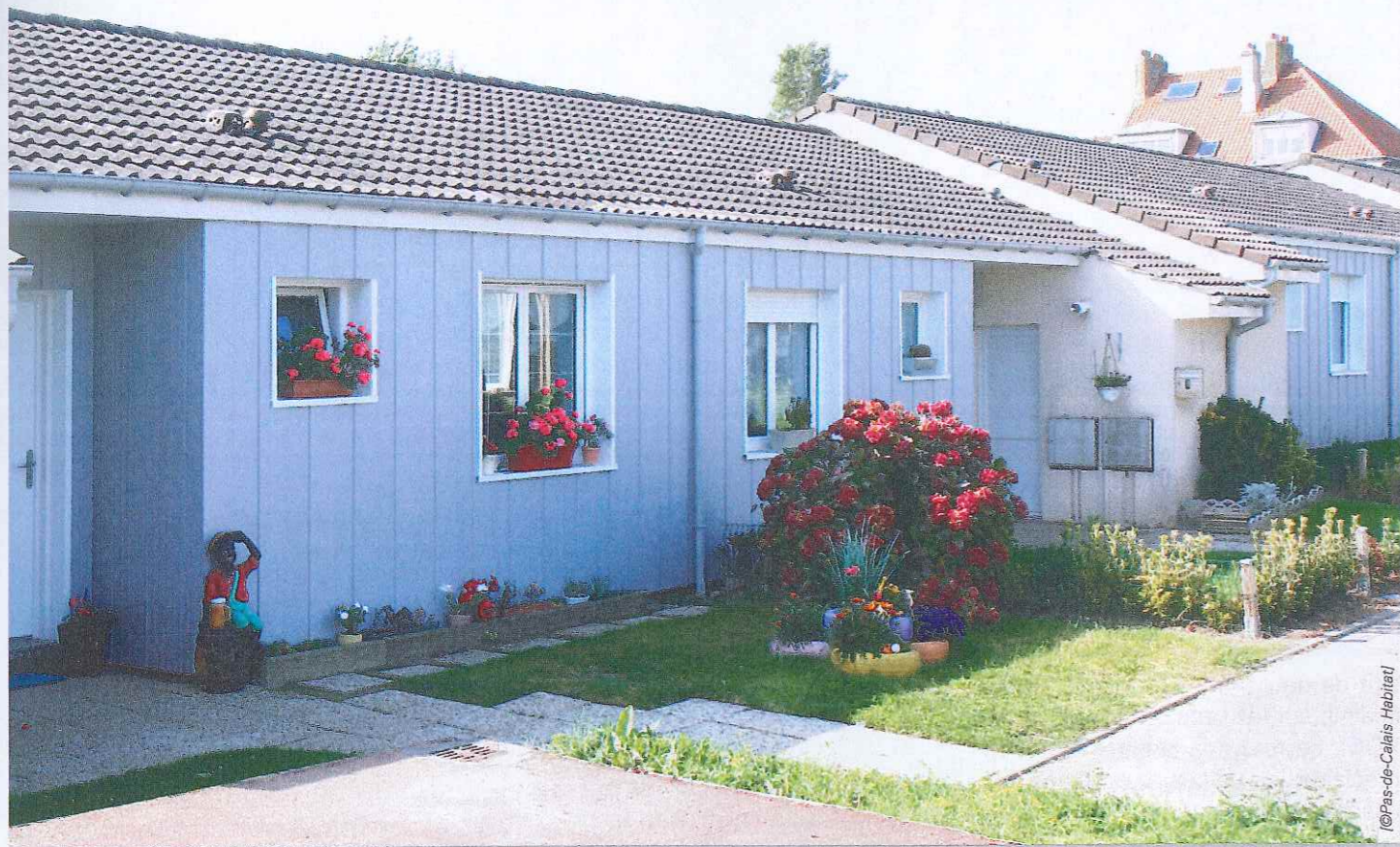
La première tranche de rénovations a concerné cinquante maisons de plain-pied.
